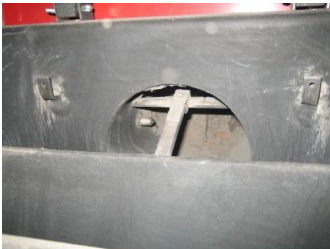
Lambdasonde i afgangsrør.
